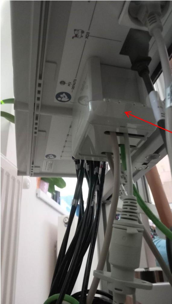
Capot de protection fixé sur le dessous du coffret électropneumatique.
